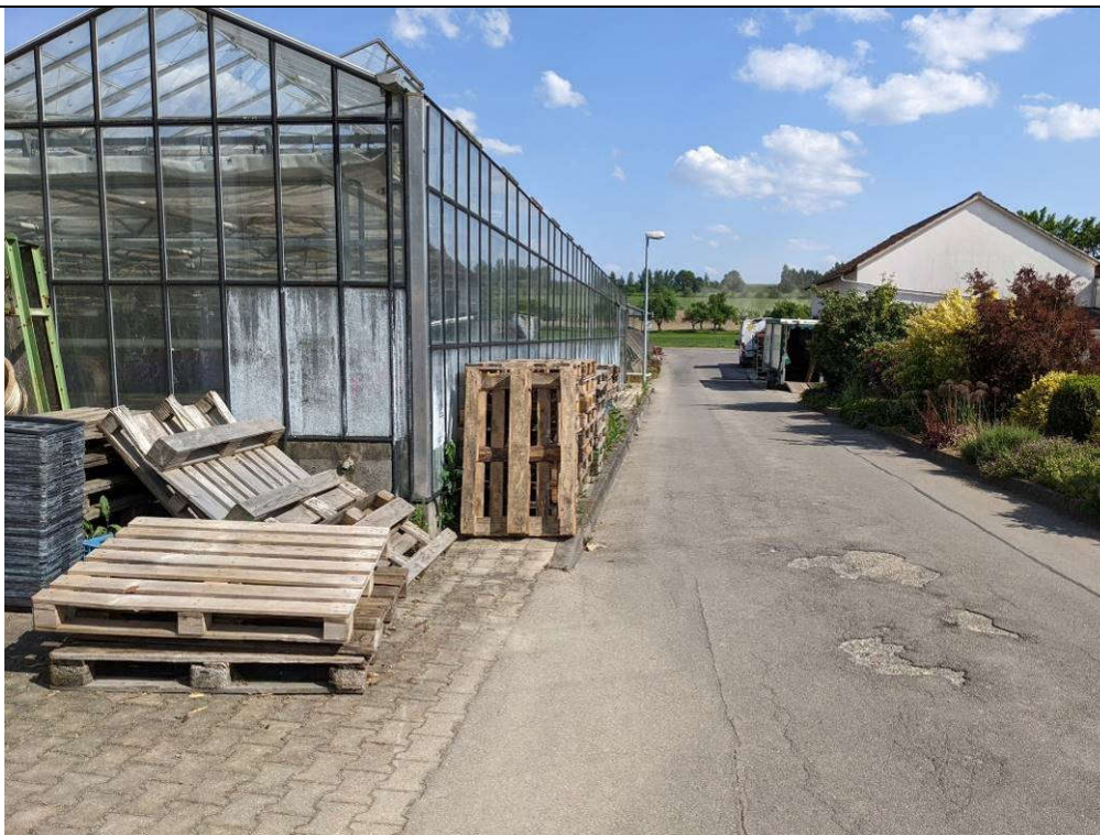
Plangebiet Bereich Kapfweg, Gärtnerei Ehmele 02.06.2023
